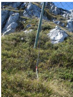
Fig. 5: esempio di completa estrazione dell'ancoraggio di monte di una rete fermaneve
